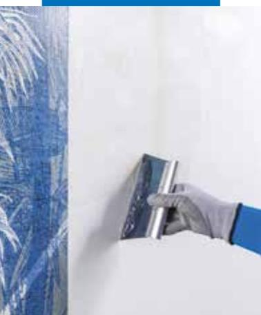
Stesura di Ultrabond Eco Decor Wet su lisciatura a base cementizia
